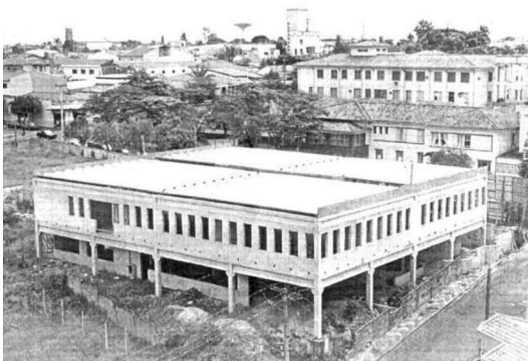
Mais adiante, as obras estariam paradas (novembro/2001)
