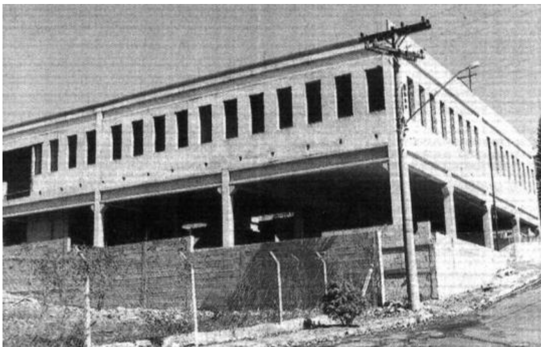
O estágio das obras três meses após o seu início
