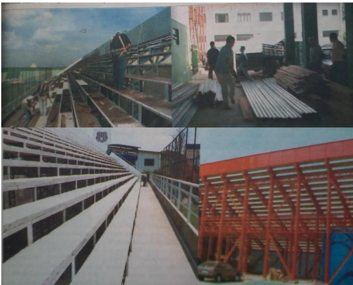
Obras de adequação foram executadas a “toque de caixa” no Estádio Antonio Guimarães, nos altos da Vila Aparecida
